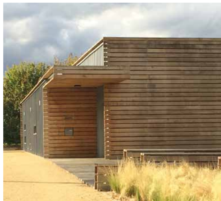
BARDAGE EN POSE HORIZONTALE
